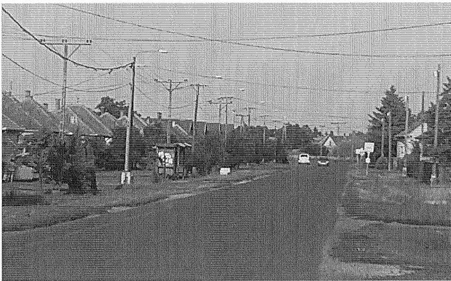
Közúti közlekedési szempontból fontos szerkezeti elem az igazgatási területet átszelő összekötő út.
