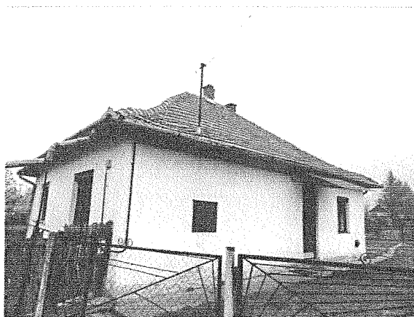
Lakás Nyugati homlokzat, bejárata
